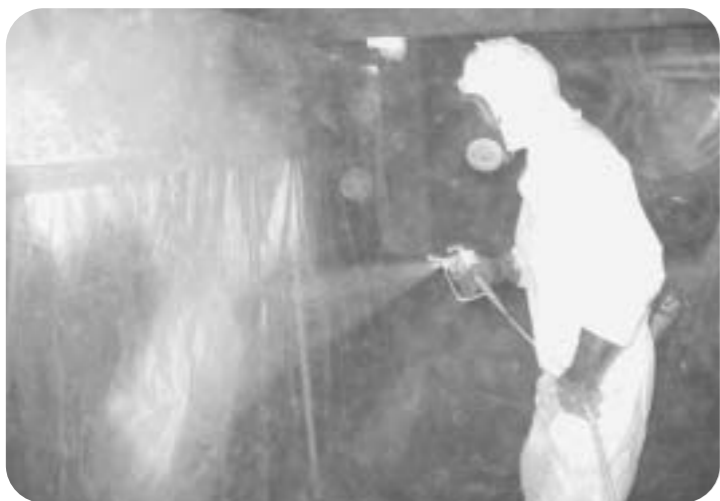
建設業労働災害防止協会の「建築物の解体等工事における石綿粉じんへのばく露防止マニュアル」より引用
