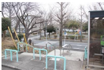
竹山二丁目南公園付近の 階段・手すり
